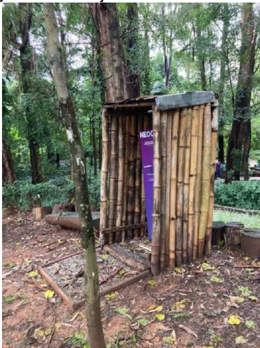
Figura 39 – Remoção da estrutura de bambu
