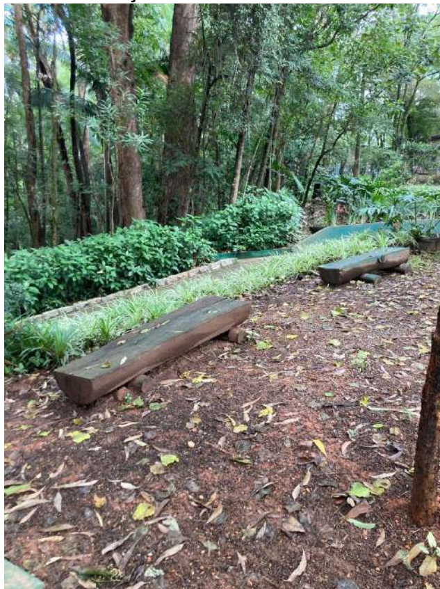
Figura 40 – Remoção dos bancos inclinados de madeira
